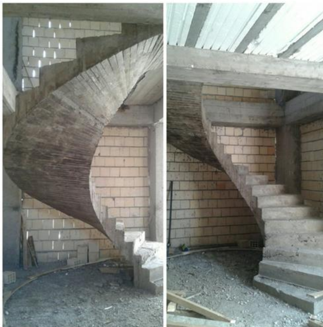
نمونه‌ای از پله پیچ اجرا شده
